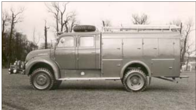
Der erste Schlauchkraftwagen, der 1955 an die BF Wiesbaden geliefert worden ist. Blinkleuchten auf Fh-Dach, Reserverad auf Fh-Dach, Fahrerhaus in Holzgerippebauweise beblecht. Werkfoto Magirus.
